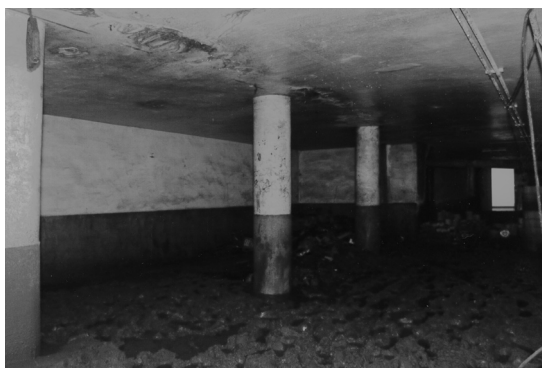
右の写真の建物には地下道がそのまま放置されていて、 建物の解体を前に市民に公開された（原義郎撮影）
