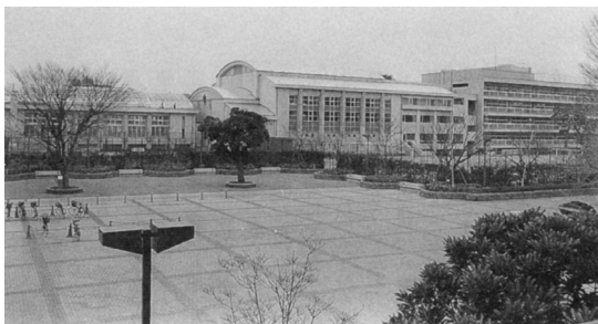
地域開放型の体育館と温水プールを併設した 市立第四中学校。平成4年6月完成
