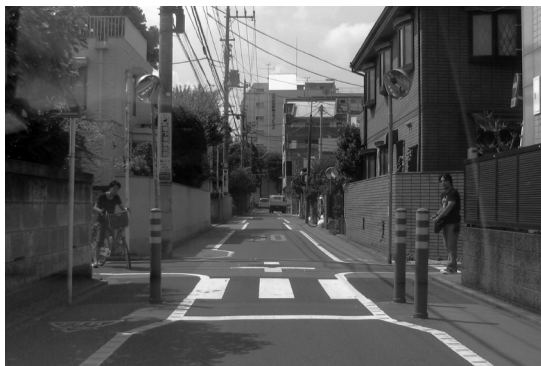
車のスピードを落とさせるボラードで 人にやさしい道づくり（吉祥寺東町宮本小路）
