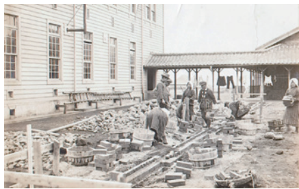
写真3-8 大村航空隊工事 (防衛省防衛研究所所蔵)
