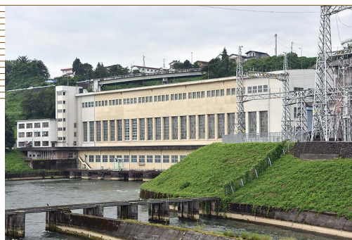
現在の千手発電所（新潟県十日町市）
