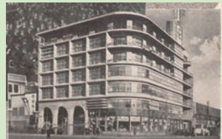
上の白木屋は江戸時代から続く大手百貨店。1932年に4階から8階までを全焼する火災を起こす前の姿をとらえた写真。この火災は日本初の高層建築火災として様々な教訓を残した。
