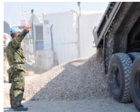
砂利敷設作業開始
