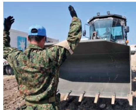
作業開始前点検を行う隊員
