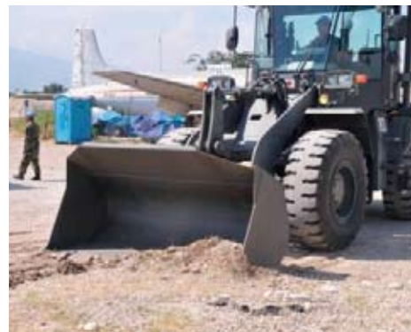
地表面掘開作業開始
