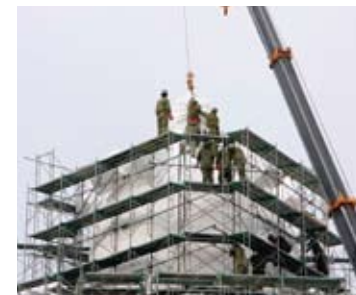
クレーンを使用しての高所作業
