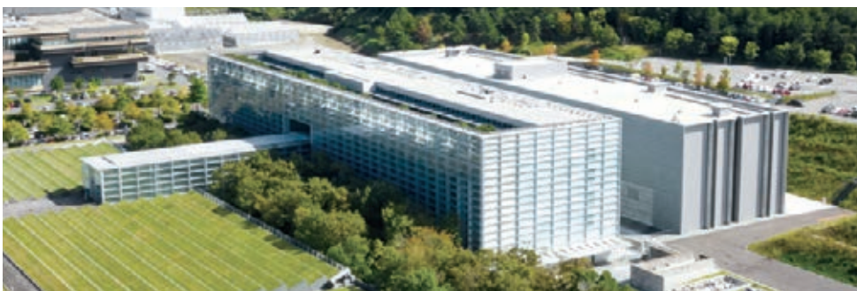
関西館（左：本館 右：書庫棟）
