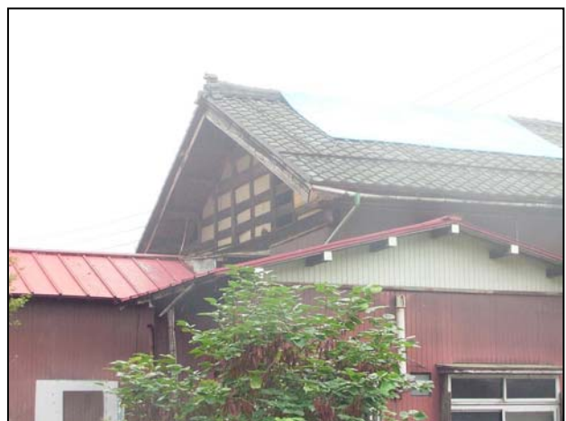
写真 (No.1) 木造家屋屋根瓦の損壊
