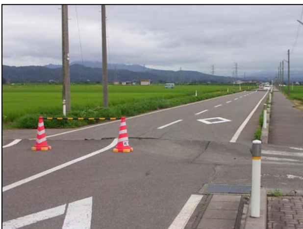
写真 (No.5) 道路の隆起
