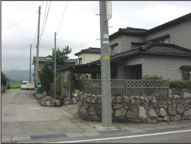
写真 (No.1) 石塀の崩落 (左奥)
