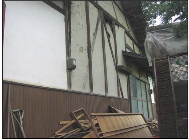
写真 (No.8) 木造家屋の壁の損壊 家の中は、柱が傾き居住不可
