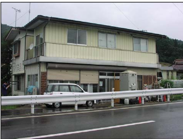
写真（No.5）木造家屋の壁の剥離
