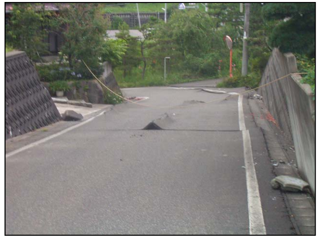
写真 (No.4) 道路の隆起
