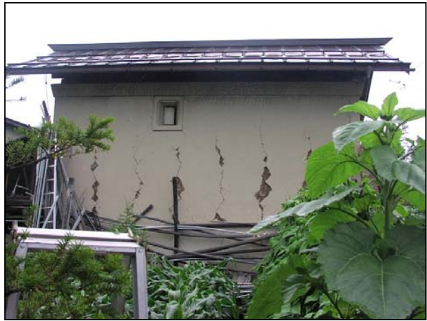
写真（No.4）土蔵の壁の亀裂と剥離
