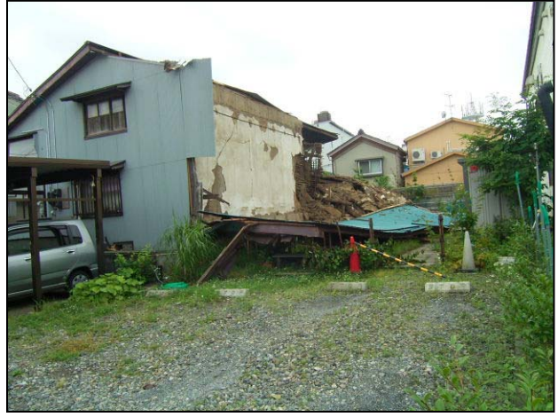
写真 (No.9) 家屋の壁の崩落
