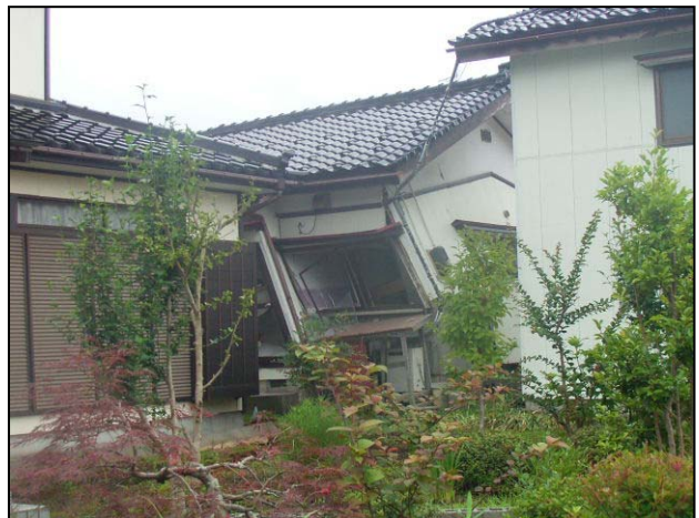
写真 (No.2) 木造家屋の倒壊
