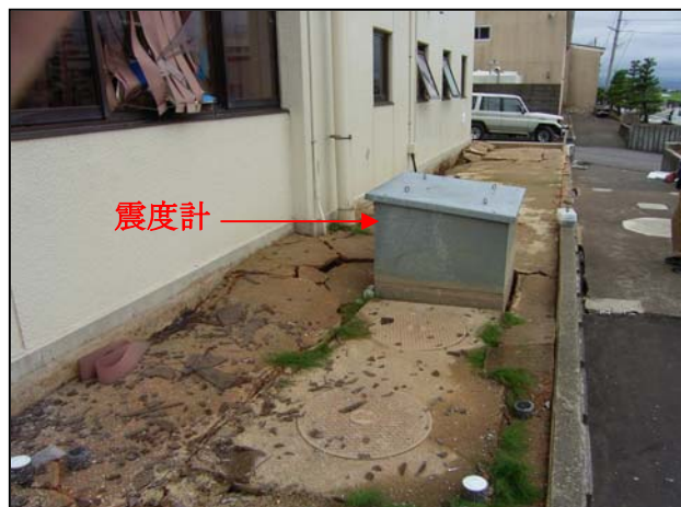
写真 震度計周辺状況 周辺地面に若干の陥没や亀裂が生じている
