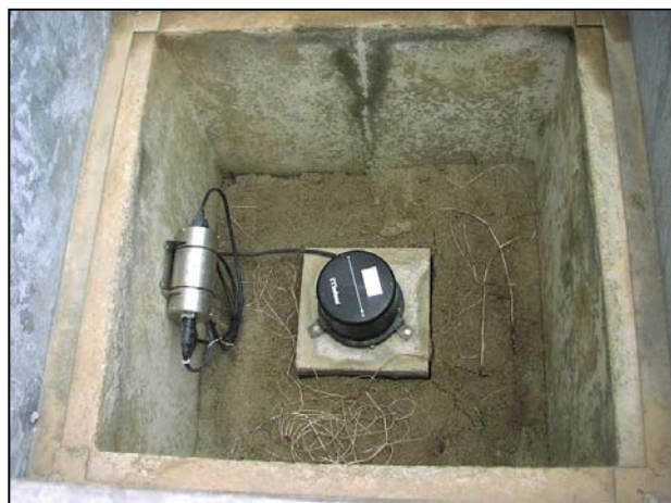
写真 震度計センサー設置環境 センサー周辺の地面に亀裂を確認
