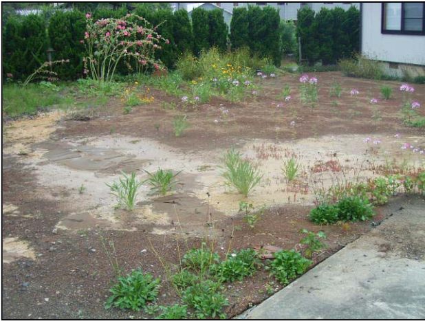
写真 (No.1) 液状化の痕跡
