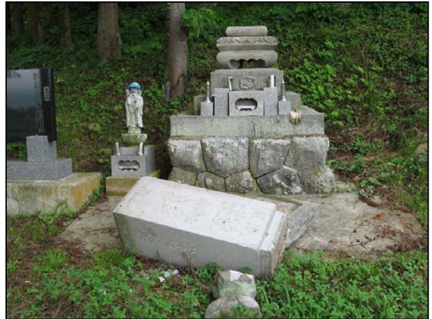
写真 (No.10) 墓石の落下
