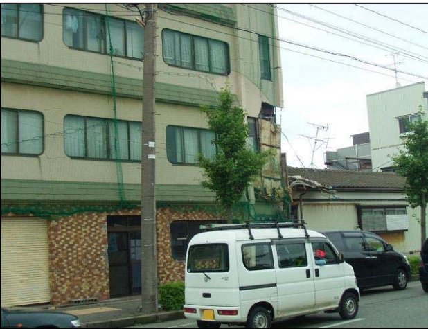
写真 (No. 4) 家屋の壁の崩落
