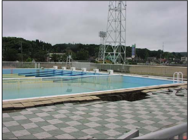
写真 (No.2) プールサイドの陥没
