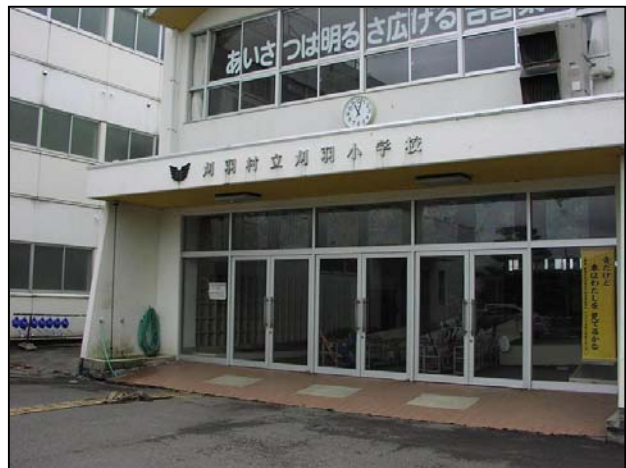
写真 (No.6) 下駄箱の転倒及び 点字ブロックの破損 (左下)
