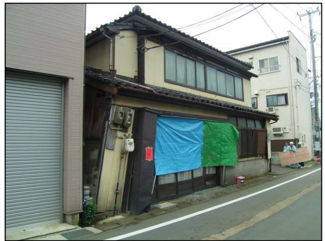
写真 (No. 7) 木造家屋1階部分の傾き
