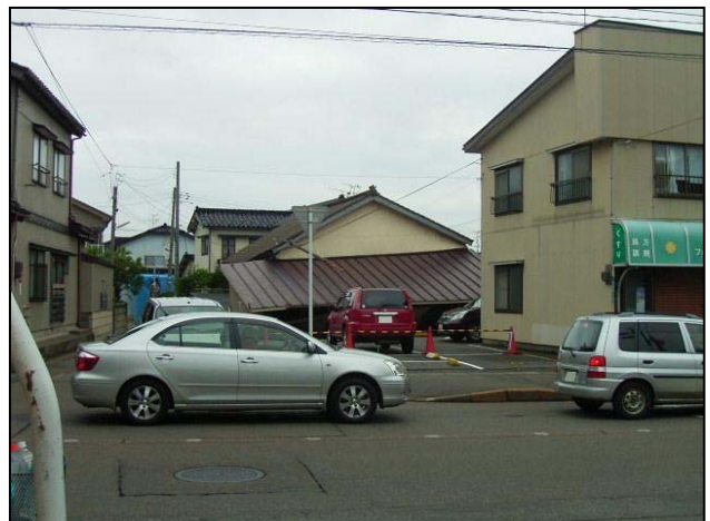
写真 (No. 1) 木造家屋の 1 階部分の崩壊
