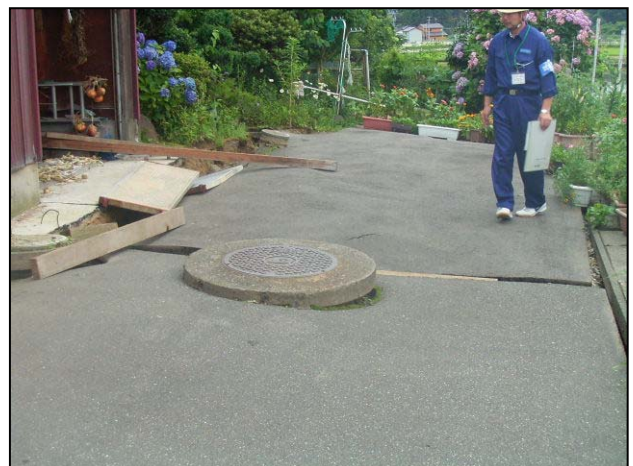
写真 (No.6) マンホールの相対的な隆起
