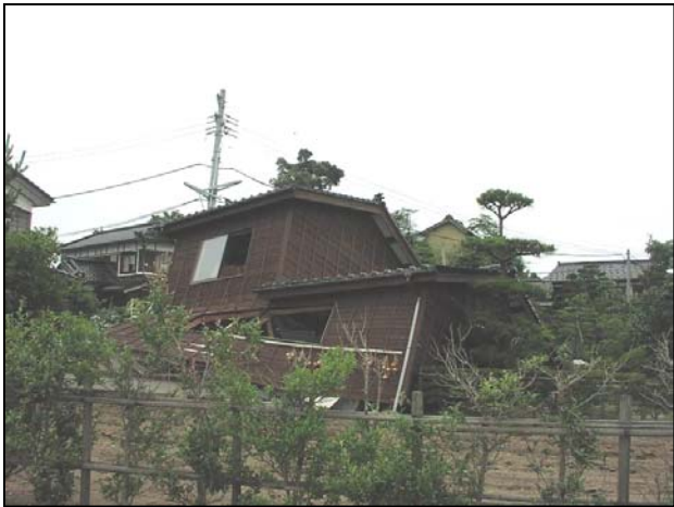
写真 (No.3) 木造家屋の倒壊
