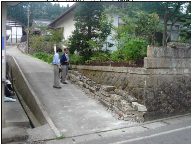
写真 (No.11) 塀の倒壊
