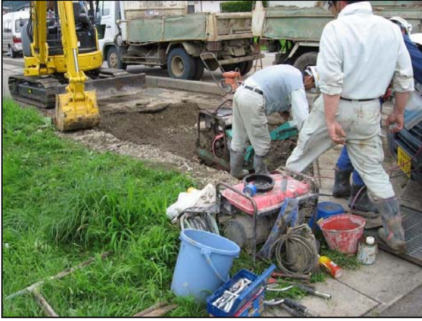
写真 (No.7) 水道管破裂復旧作業現場
