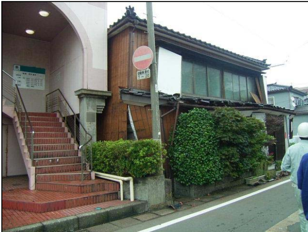
写真 (No.10) 木造家屋の傾き
