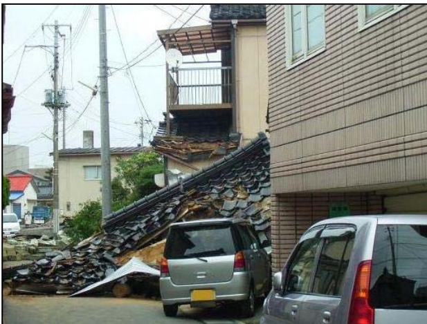
写真 (No.12) 木造家屋の崩壊
