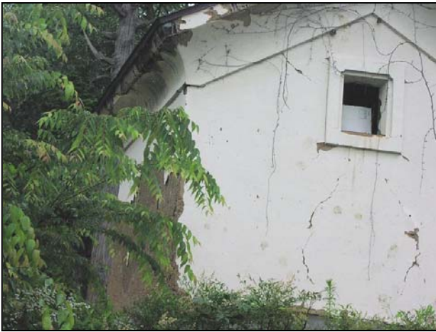
写真（No.3）土蔵の壁の剥離
