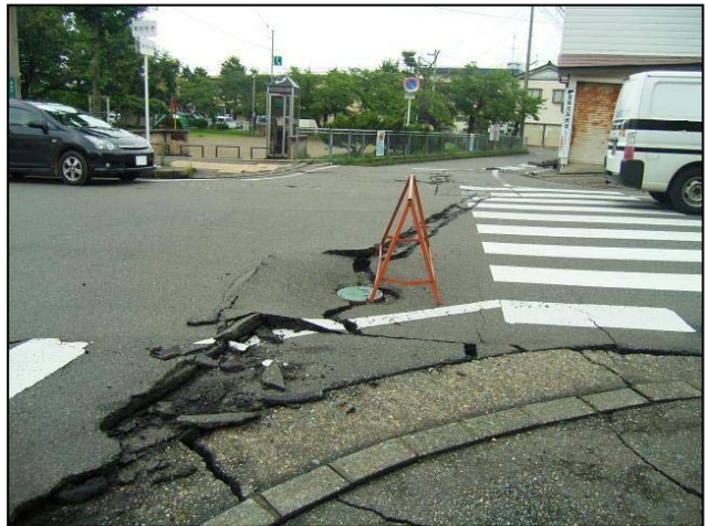
写真 (No. 5) 道路の亀裂
