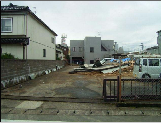
写真 (No.8) 木造家屋の崩壊
