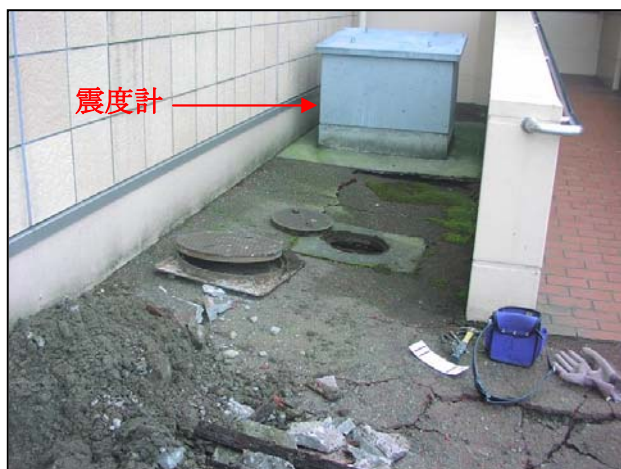
写真 震度計周辺状況 周辺地面に亀裂が生じている
