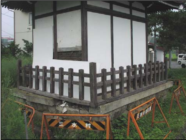
写真（No.1）お堂の被害状況 基礎石垣の一部崩壊、社屋壁の剥離、 社屋全体の移動（北西へ約 20cm）
