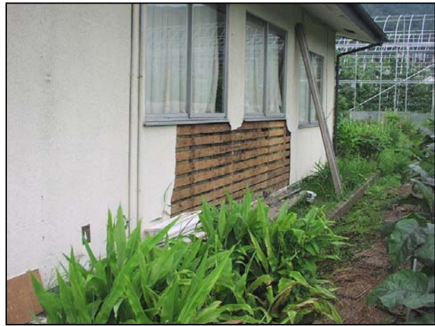
写真（No.6）木造家屋の壁の剥離
