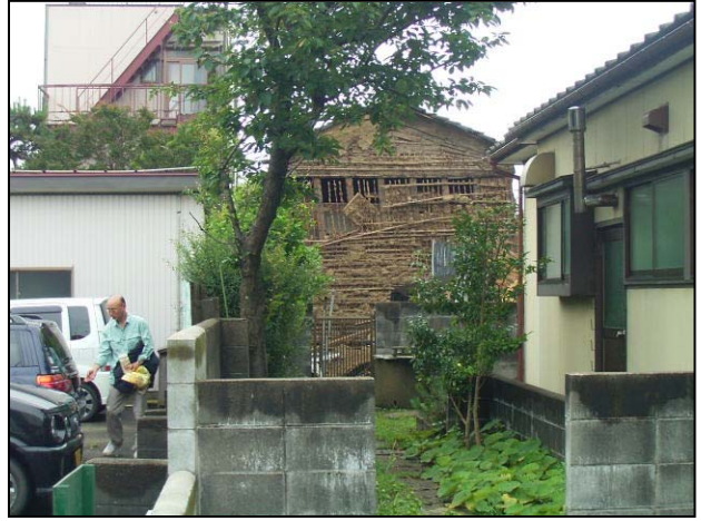
写真 (No. 3) 家屋の壁の崩落
