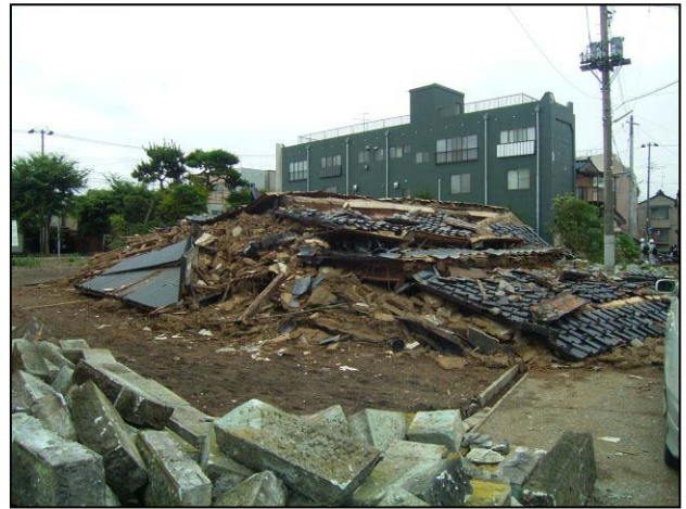
写真 (No.13) 木造家屋の崩壊
