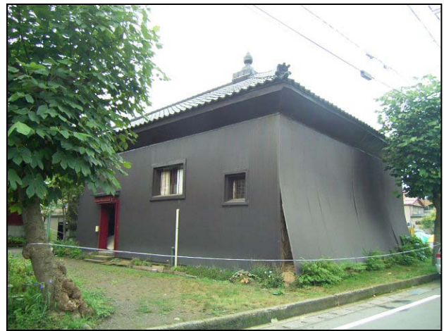
写真 (No.11) お堂壁の損壊
