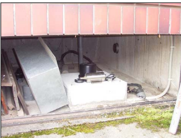
写真 震度計の設置環境（異常なし）
