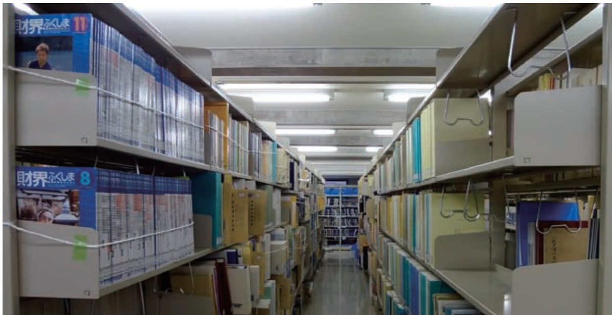
福島県立図書館 復旧した書庫（写真提供：福島県立図書館） 余震に備えて、落下しやすい部分にロープを張っている。
