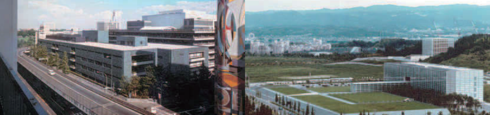
左から 新館 完成時外観（北西方向から） 関西館 完成時外観（北西方向から）
