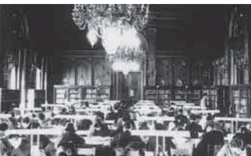
旧赤坂離宮仮庁舎（花鳥の間）
