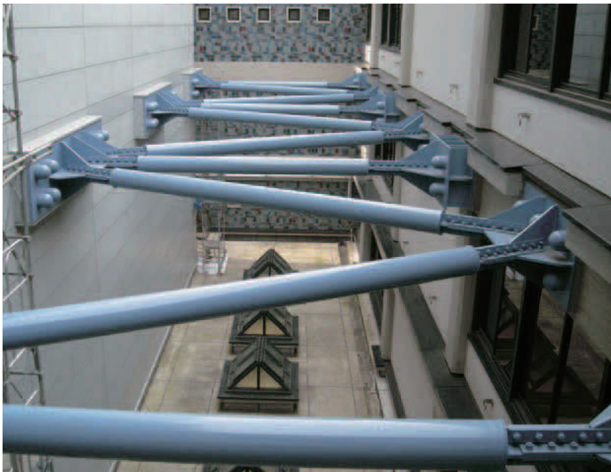
東京本館耐震改修工事で設置された、書庫棟（左側）と事務棟（右側・奥）をつなぐ鉄骨ブレース
