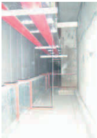
地下書庫（防水のための二重壁）
