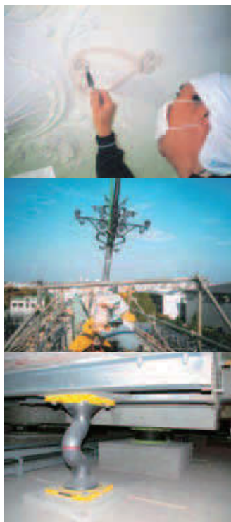
上：天井の装飾の復元作業 中：開館 当時から残る避雷針を復元し、取り付 ける 下：免震装置
