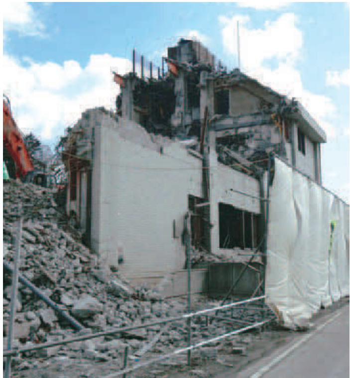
写真2 解体工事中の女川町生涯教育センター(2012年3月15日撮影)
