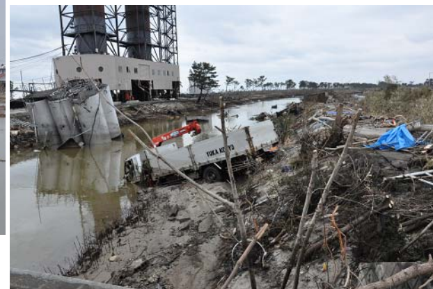
高砂南部排水機場 (宮城野区蒲生)
