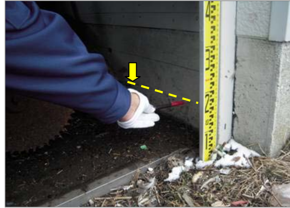
写真 19 津波の痕跡（図 26 の 19）
