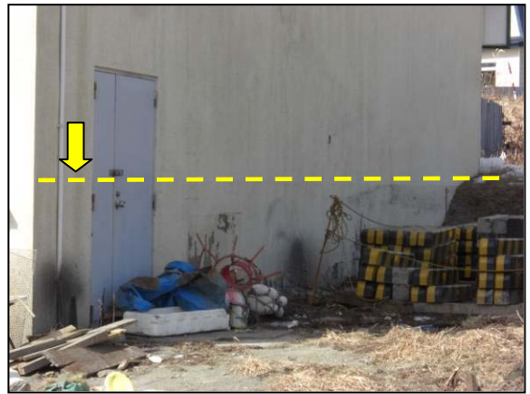
写真 6 津波の痕跡（図 10 の 6）
