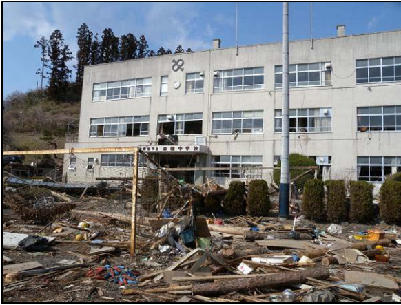
写真 28 校舎の被害状況
