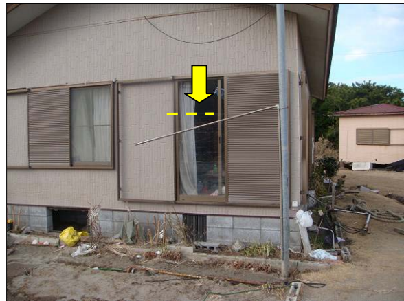
写真 1 津波の痕跡（図 11 の 53）
