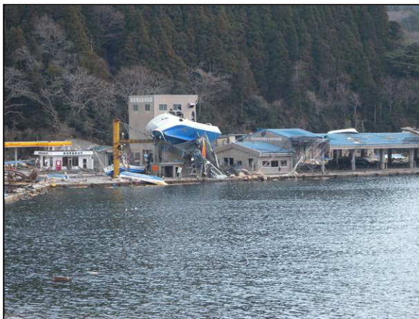
写真 20 漁港外側の漁協施設の被害状況
