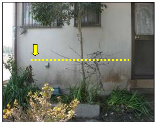
写真 11 津波の痕跡（図 15 の 71）
