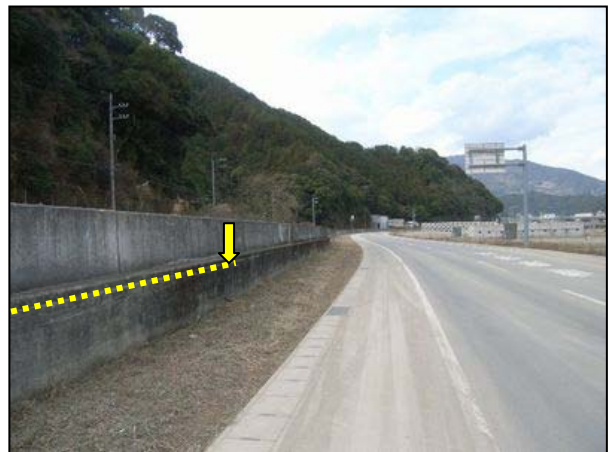
写真 14 津波の痕跡（図 19 の 74）
