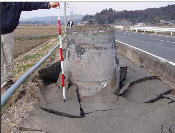
写真 21 常陸太田市玉造町 玉造十字路付近マンホールが浮上
