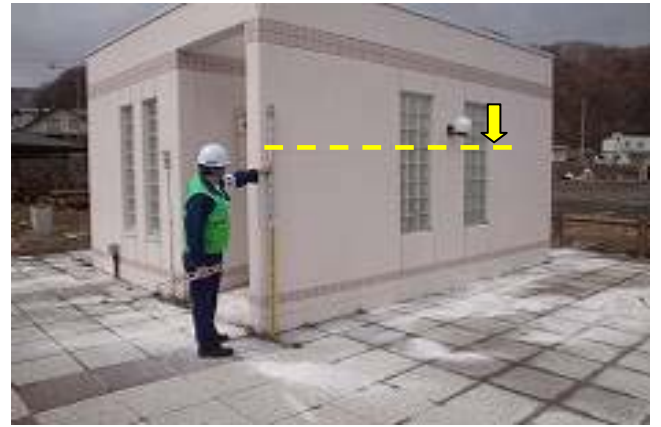
写真 9 津波の痕跡（図 14 の 9）
