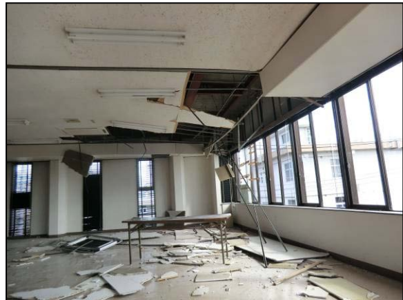
写真 33 真岡市 芳賀地区広域行政センターの被害 壁の破損（上）、天井の破損（下）
