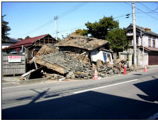
写真 15 松島町 木造納屋の倒壊
