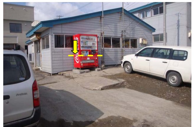
写真 11 津波の痕跡（図 16 の 11）
