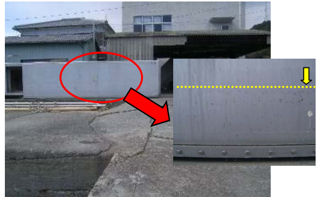
写真 10 津波の痕跡（図 14 の 70）
