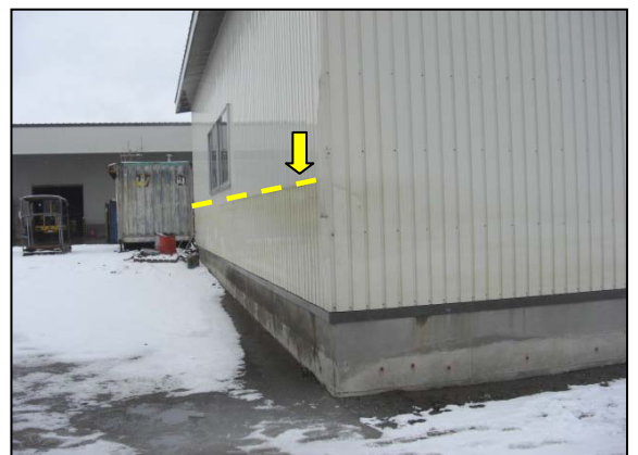
写真 8 津波の痕跡（図 12 の 8）
