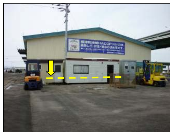
写真1 津波の痕跡（図3の1）
