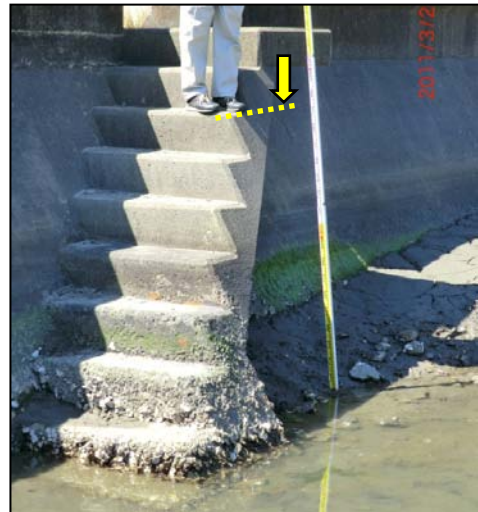
写真 2 津波の痕跡（図 4 の 62）
