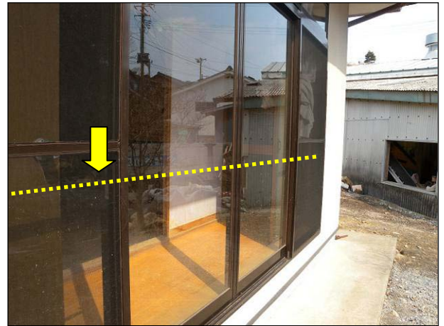
写真 24 津波の痕跡（図 13 の 33）
