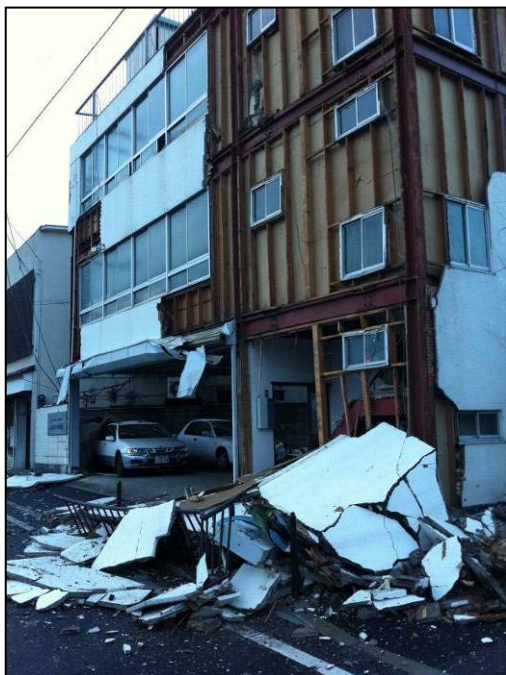
写真 17 福島市霞町付近 ビル外壁の破損・落下
