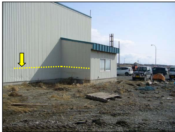
写真 13 津波の痕跡（図 19 の 13）
