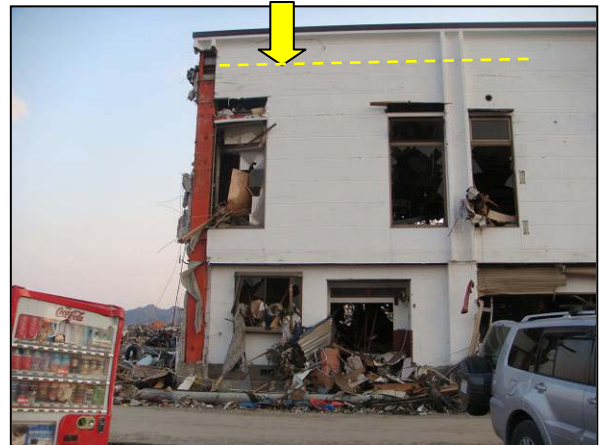
写真 30 津波の痕跡（図 15 の 35）
