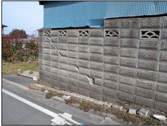
写真 13 栗原文化会館前の民家 ブロック塀の破損
