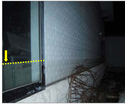
写真 18 津波の痕跡（図 25 の 18）
