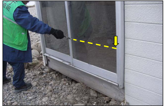
写真 10 津波の痕跡（図 15 の 10）
