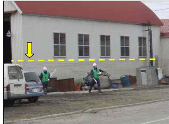
写真 7 津波の痕跡（図 11 の 7）
