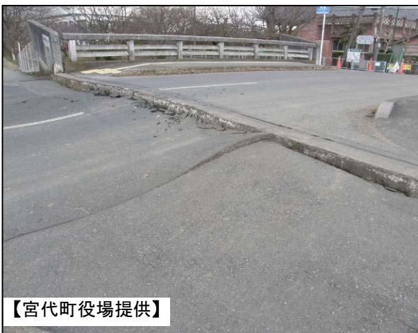
写真 29 亀裂南埼玉郡宮代町百間 橋梁接続部の道路陥没及び亀裂
