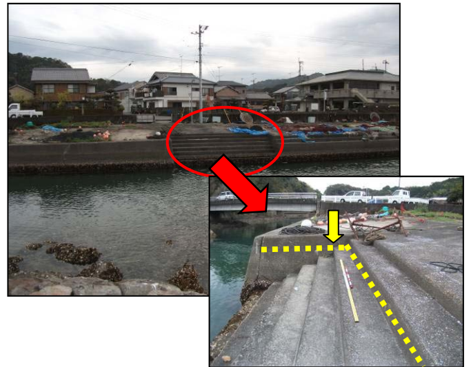
写真 13 津波の痕跡（図 17 の 73）
