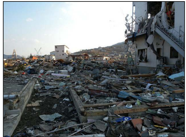
写真 32 大船渡市野々田地区の被害状況
