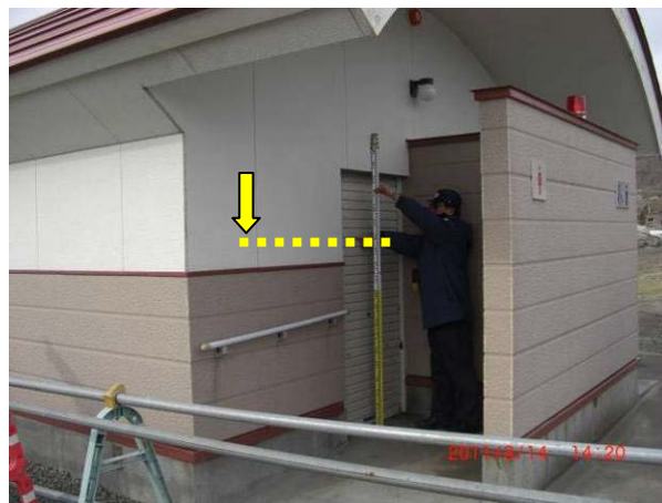
写真 17 津波の痕跡（図 23 の 17）
