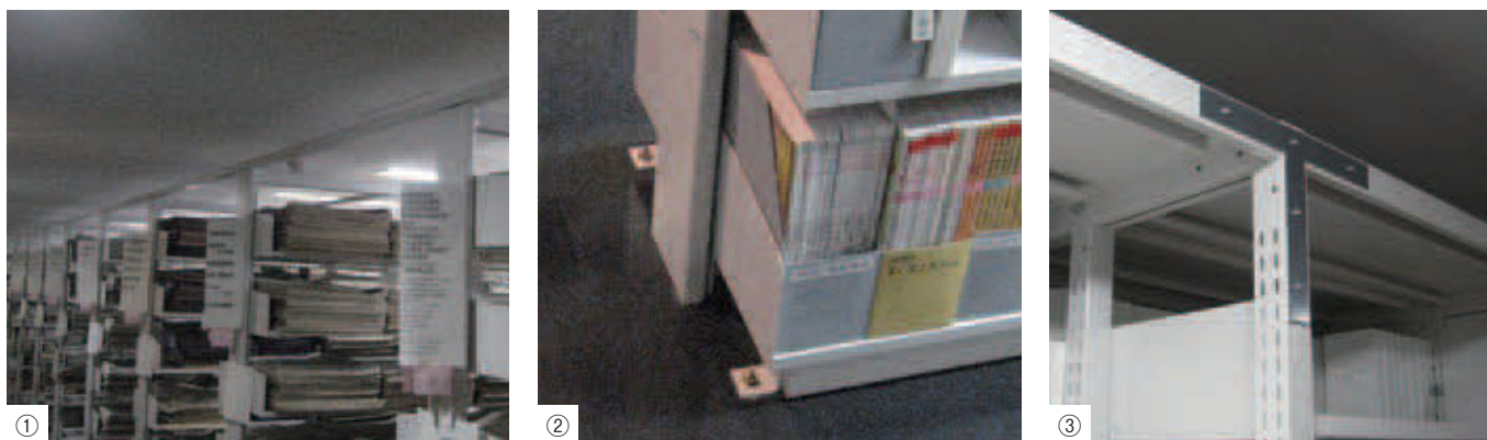
写真6 書架転倒対策例 ①天つなぎ（震災以前から） ②床止め（震災以前から） ③筋交い強化（震災後から）
