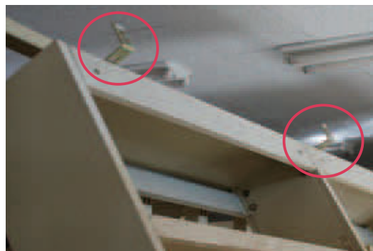
写真3 留め金具が手前2か所のみで奥になかったため、バランスが悪く倒壊した例
