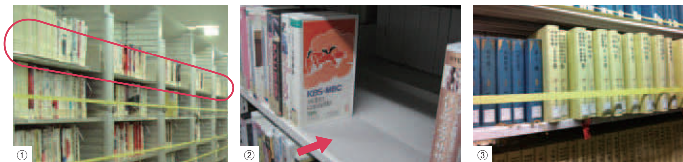
写真7 落下防止対策例 ①落下防止バー（最上段のみ） ②落下防止シート ③結束テープ（2012.12.7地震（仙台市泉区震度4）後）
