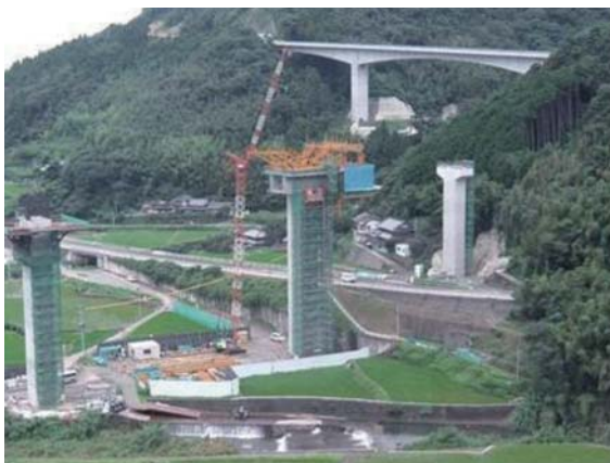
工事状況（千綿川橋りょう）
