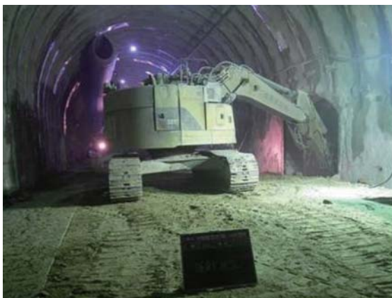
工事状況（千綿トンネル）
