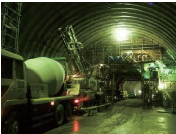
工事状況（鈴田トンネル）
