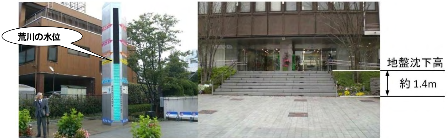
写真 3-2 江戸川区役所の水位標識と江戸川区役所の正面玄関の階段
