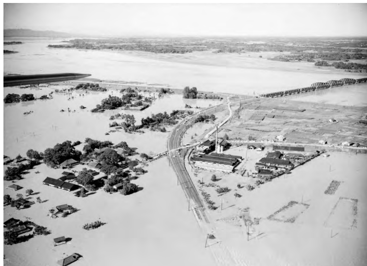
写真 2-2昭和22年カスリーン台風(東武日光線上空より利根川栗橋方向を望む、国土交通省江戸川河川事務所記録写真)
