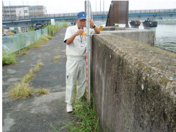
写真 3-4 荒川左岸嵩上げパラペット
