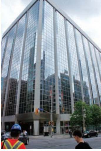
(左) 議会調査情報局が入居するオフィスビル (右) アナリストの執務室
