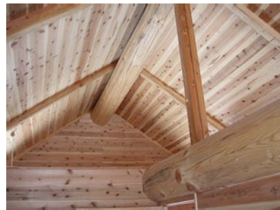
写真5 スギの内装材とカラマツの梁
