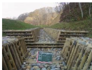
間伐材等を利用した流路工 (公共土木事業における間伐材等の利用推進)
