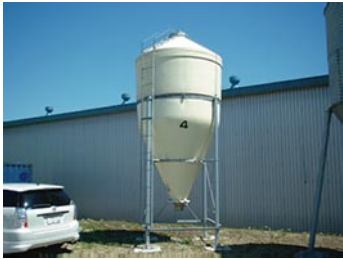
写真7 屋外サイロ (FRP製)
