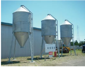
写真6 屋外サイロ (鋼コルゲート製)
