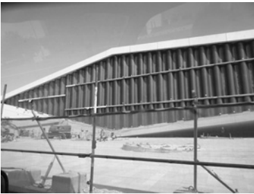
建設中のカタール国立図書館
