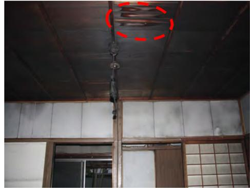
No.6 六畳間の天井、天井全体に雨漏りが見られる。赤丸内はまだ水滴が残っている。中央は蛍光器具吊下げ部材。
