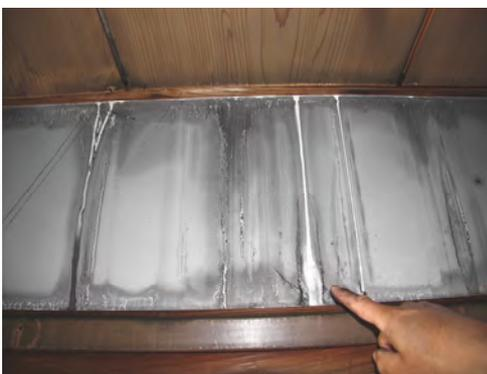
No.3 廊下壁面、雨の滴が火災の煤を洗い流している
