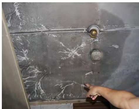
No.4 台所の天井、雨漏りが天井に染みている
