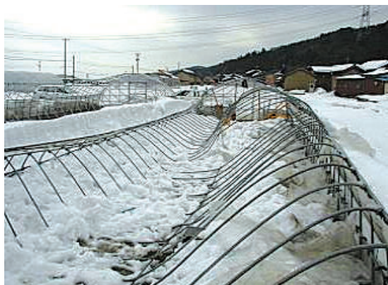
「平成18年豪雪」により倒壊したハウス
