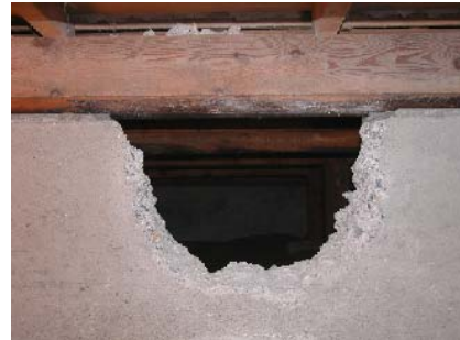
写真-1 防蟻工事で破壊された布基礎
