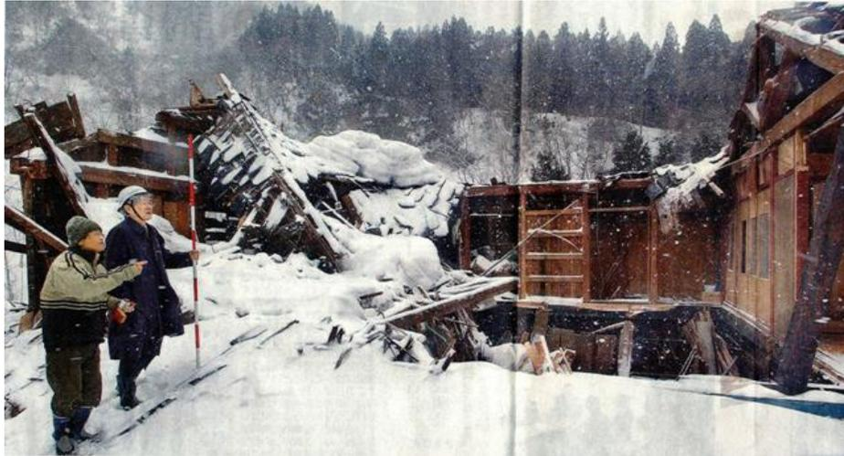
写真-5 雪の重さで破壊した家屋 雪荷重と破壊の関係を調査する筆者ら(平成18年1月30日「北陸中日新聞」掲載写真)。
