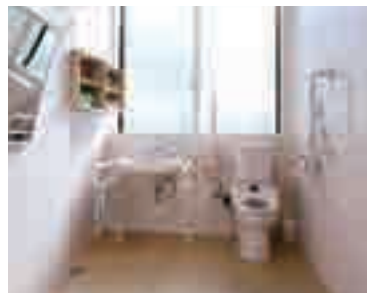
車椅子用にトイレを改修。
