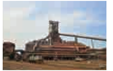
君津製鐵所のシンボルである高炉。
