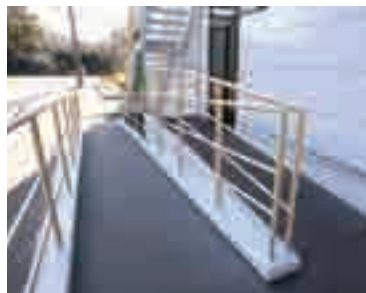
スロープを設置。
