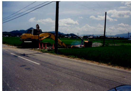
写真－2 井戸掘削状況
