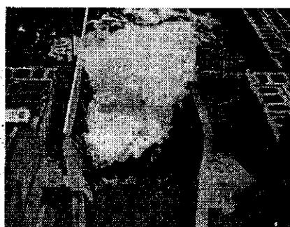
写真-10 静水池改良による流況 Q=350 \text{ m}^3/\text{sec}
