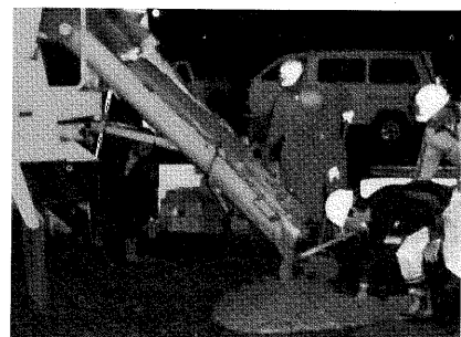
Photo 2 実機製造によるECCのフレッシュ性状
