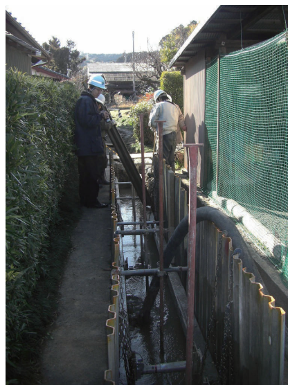
写真－1 施工の様子
