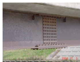
写真1 ボルトを使用した鋼橋の摩擦接合継手の例
