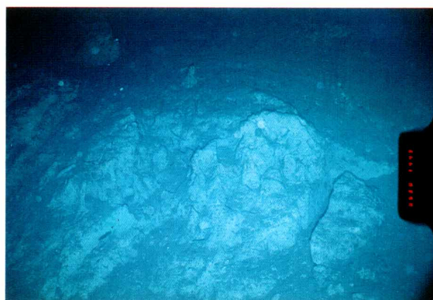
写真 2 断層崖基底付近の珪藻質泥岩の露頭（図 4 の地点 B）。わずかに崩壊している。
