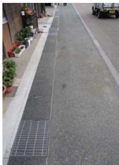
図 3-93 道路舗装と側溝上蓋の表層を合わせた例（愛知県犬山市）
