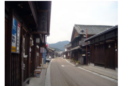
図3-81 連続する道路側溝の上蓋 (三重県亀山市関宿)
