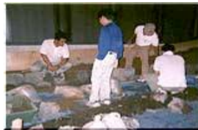
図 3-77 石工科（間知積の石割作業）
