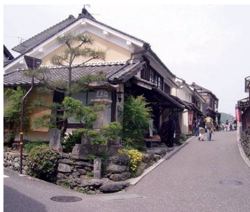
図 3-13 現在の護国地区のまちなみ 地元住民の理解と協力により、建物の修復、景観整備、電柱撤去等を実現
