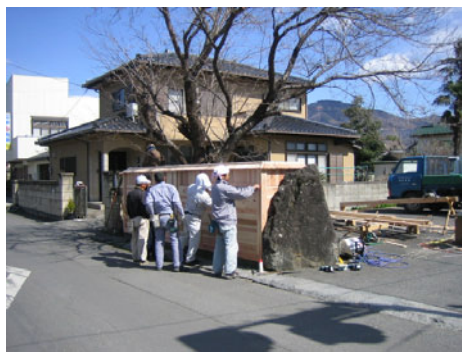
図3-63 杉板で覆った修景作業の様子
