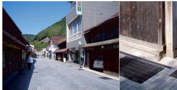
図 3-96 スリット型側溝の整備事例（山口県津和野町本町・祇園丁通り）
