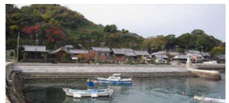
図 3-73 呉市御手洗地区で整備された雁木
