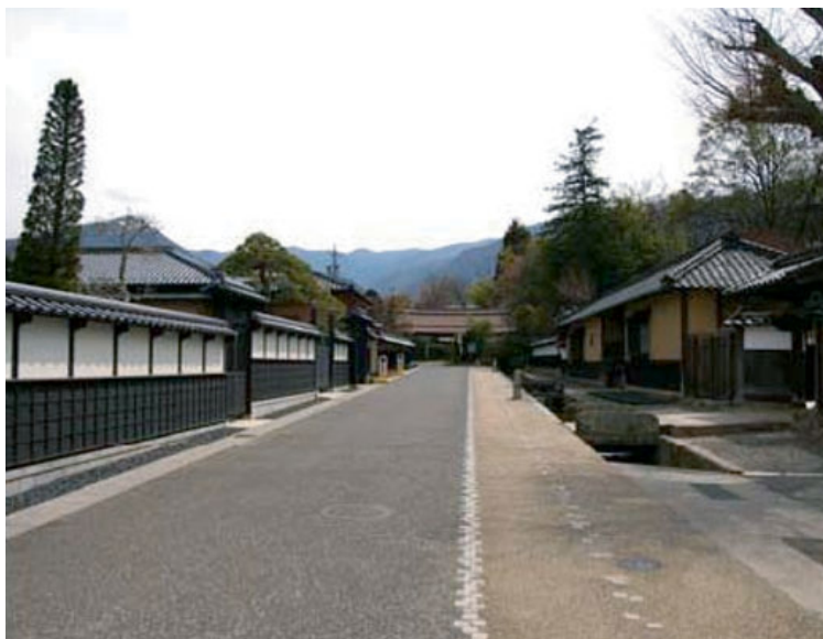
図 3-90 自然石をアラレ状に舗装し歩行部を示した事例（長野県長野市松代地区）
