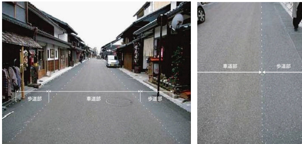
図 3-87 舗装の色の違いにより車道と歩行空間を明示した例（愛知県犬山市）
