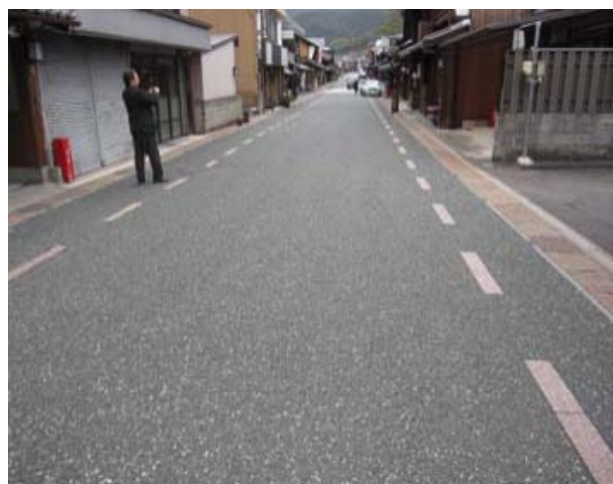
図 3-84 自然石アスファルト舗装の例(岐阜県美濃市)
