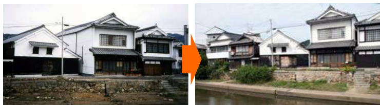
図 3-45 柳井川の護岸整備(左:整備前 右:整備後)
