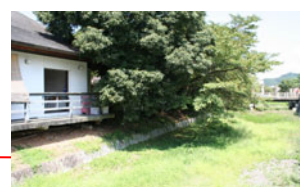
立花船町線船町交差点周辺 修景水路整備事業
