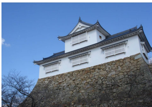
図 3-23 復元整備事業により建設された備中櫓
