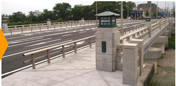
図 3-72 整備後の北大路橋
