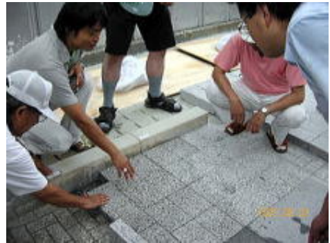
図 3-56 施工時に舗装材を再確認する様子
