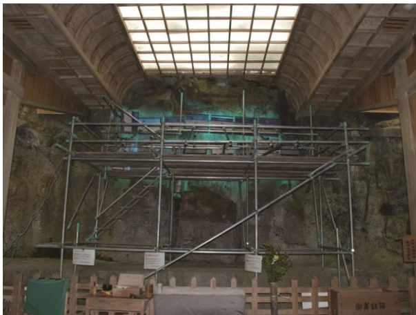
殺菌紫外線照射による 磨崖仏表面に着生する生物の除去
