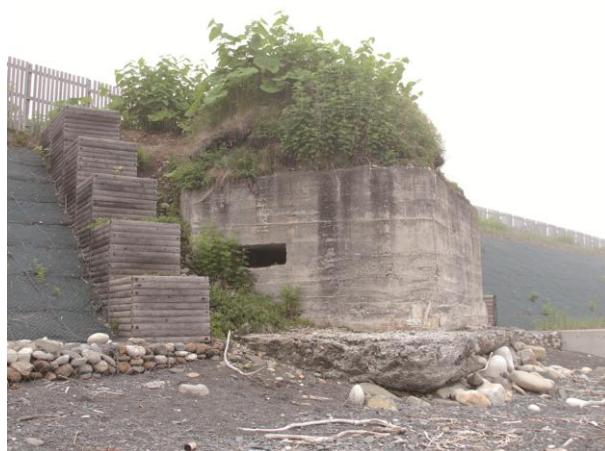
北海道帯広の海岸に残る太平洋戦争当時のコンクリート製トーチカ。現在は 波の浸食により徐々に海へ流されつつある。
