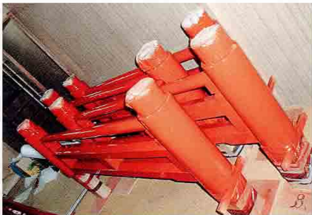
木曾で塗装中の高欄部分
