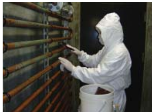
覆屋内除菌清掃の様子 (写真提供：イカリ消毒株式会社)
