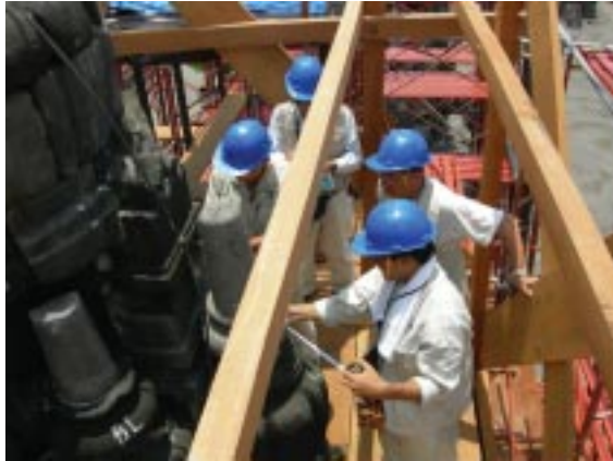
ガルダ祠堂 解体が始まった頂部の調査
