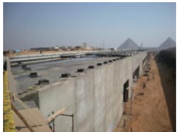
建設中の「大エジプト博物館保存修復センター」
