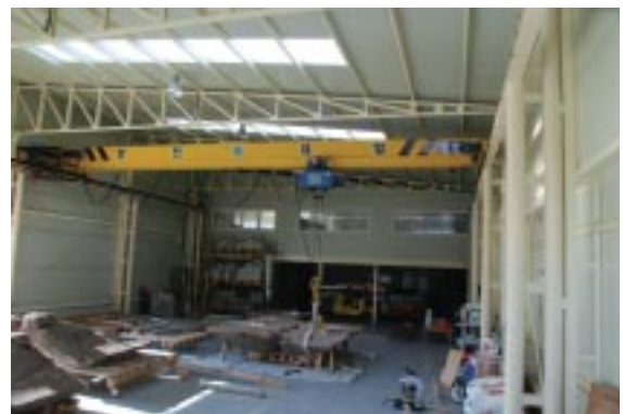
感恩寺三層石塔の保存修復工事現場
