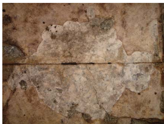
天文図取外し作業終了後の天井
