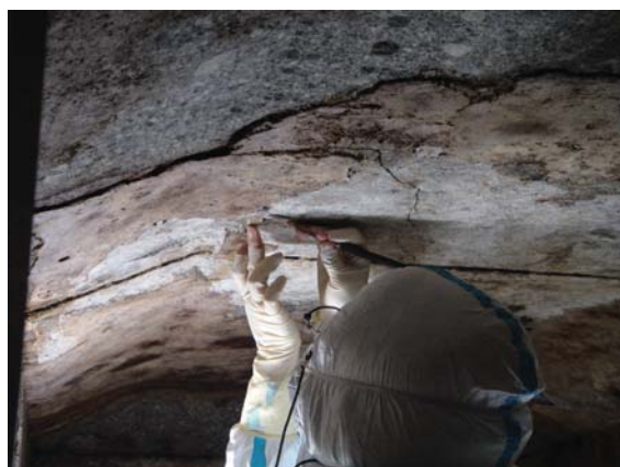
天文図取外し作業の様子
