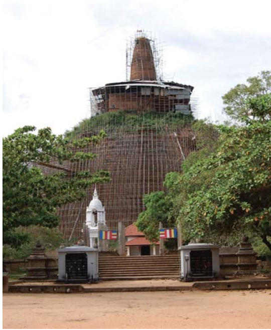
修復中のアバヤギリ大塔（アヌラダプラ遺跡群）
