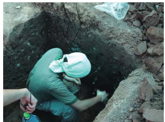
土壌水分センサーの設置作業
