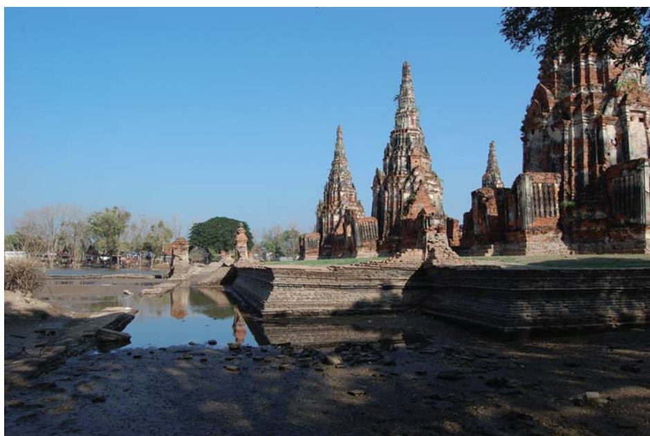
寺院遺跡の洪水被害（壁に泥が付着した範囲が最大浸水位を示す）
