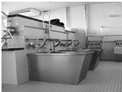
職員の腰痛予防のために、独自に開発した浴槽
