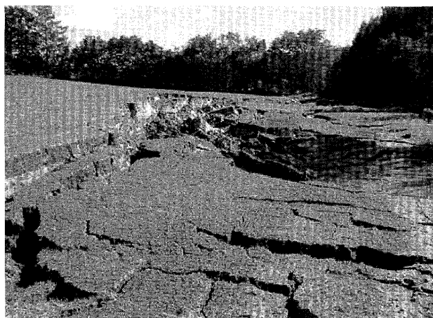
写真—2 端野町協和の農地陥没
