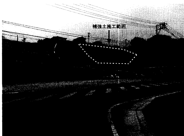
写真—9 山元町造成宅地（位置⑩）被害状況（図—2 崩壊 A）
