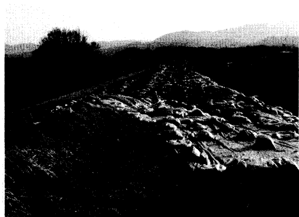
写真一7 角田市野田地区河川堤防（位置⑥）被害状況
