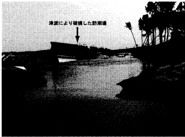
写真一4 亶理町鳥の海地区（位置④）防潮堤被害状況
