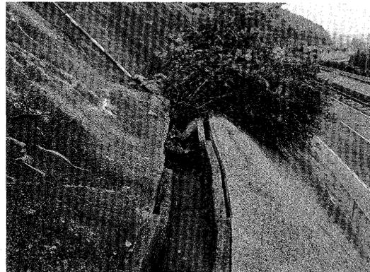
図三 吹付けコンクリート斜面でのスライド破壊の発生状況
