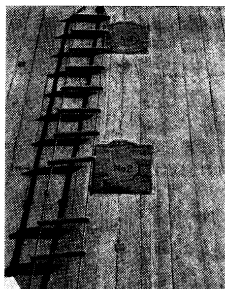
写真-2 土圧計取付け状況
