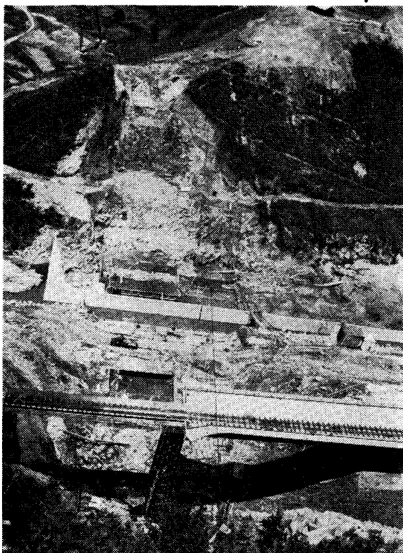
写真—1 打設現況 (43.6.21 写す)
