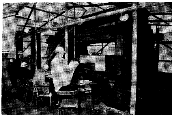
写真-3 載荷試験装置
