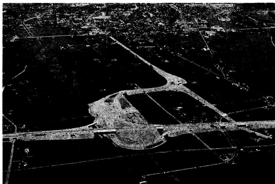
写真—2 姿をあらわした北上インターチェンジ (仮称) 第1 I C はトランペット型、第2 I C はY型、面積約11万㎡、連結道路国道107号バイパス (昭和51年5月撮影)
