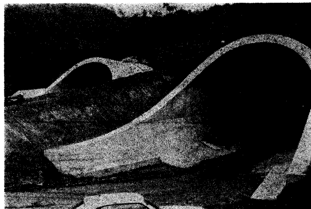
写真—1 上下線分離している平泉トンネル北口
