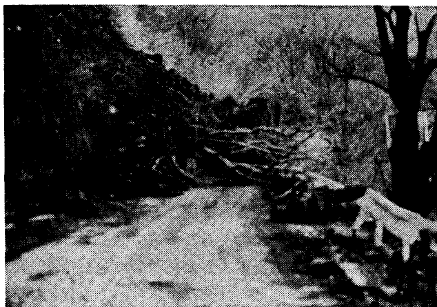
写真-2 主要地方道修善寺下田線，天城湯ヶ島町与市坂地内
