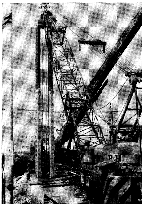
写真 ウインチ引抜き機
