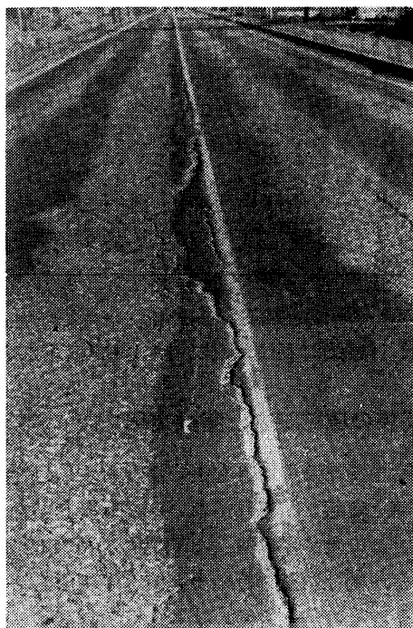
写真—1 凍上そのものによる舗装破壊
