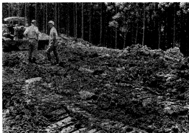
写真—2 森林地帯の土工の状況
